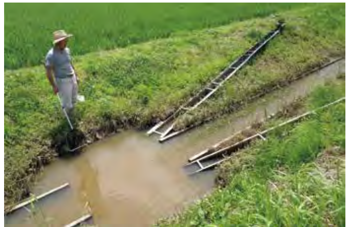
生物多様性配慮活動例：魚道
